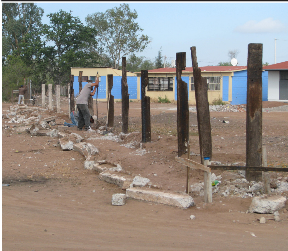
Reparando el cerco de la Escuela Sebastián González. Foto: Armando Sánchez
